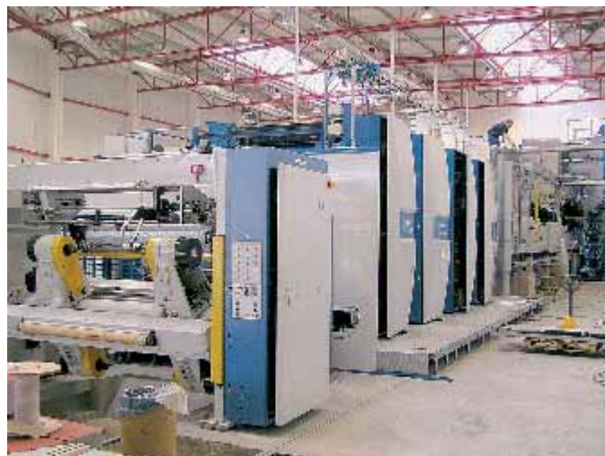
Záběr z instalace rotačky Compacta 618
