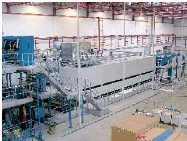
Instalace sušicího tunelu Vits-Rotoline
